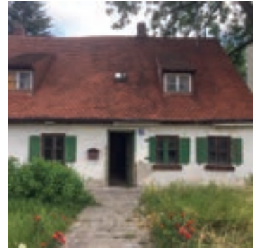
Vor der Renovierung
