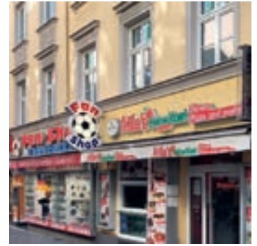
Vor der Renovierung
