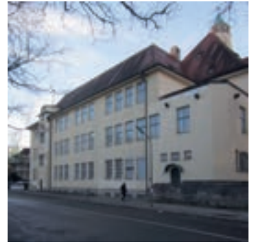
Vor der Renovierung
