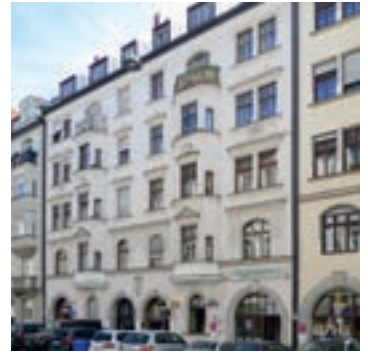
Vor der Renovierung
