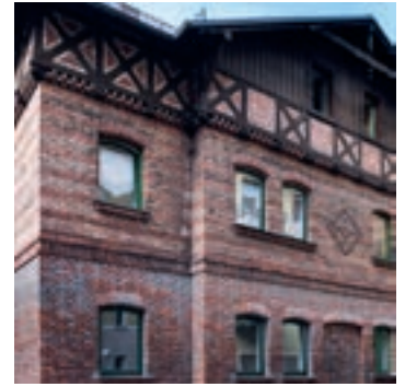
Vor der Renovierung
