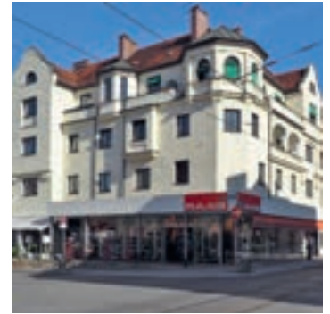
Vor der Renovierung
