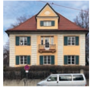
Vor der Renovierung
