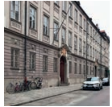
Vor der Renovierung
