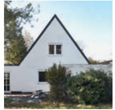
Vor der Renovierung
