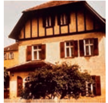
Vor der Renovierung
