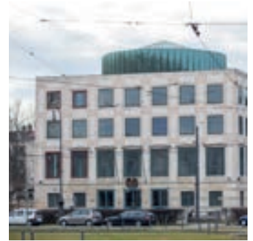
Vor der Renovierung
