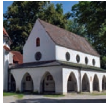
Vor der Renovierung
