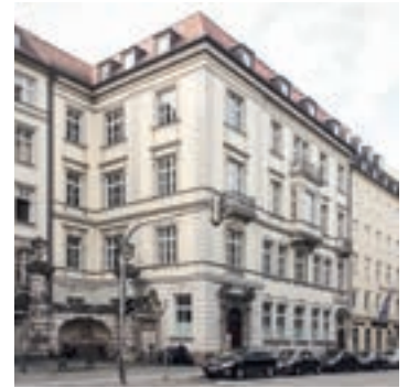
Vor der Renovierung
