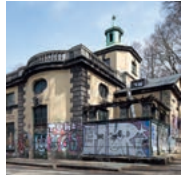
Vor der Renovierung
