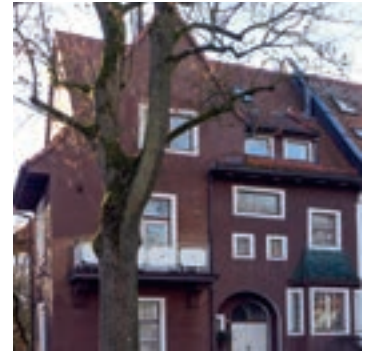
Vor der Renovierung
