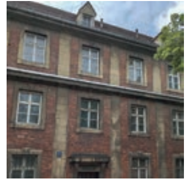
Vor der Renovierung
