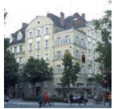
Vor der Renovierung
