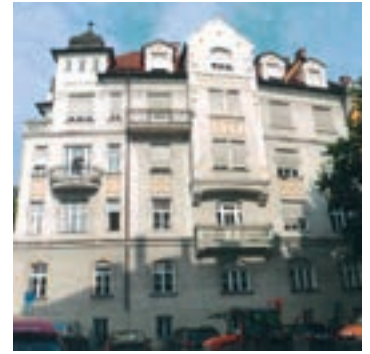
Vor der Renovierung
