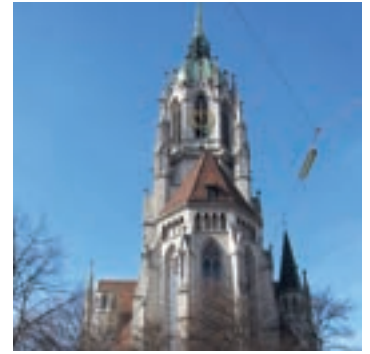
Vor der Renovierung
