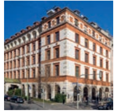
Vor der Renovierung
