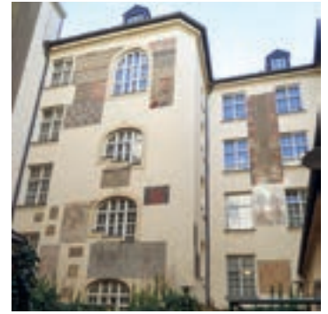
Vor der Renovierung
