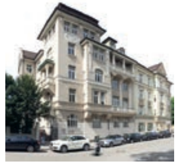
Vor der Renovierung
