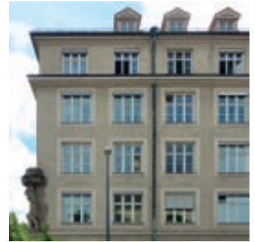
Vor der Renovierung
