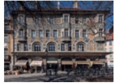
Vor der Renovierung
