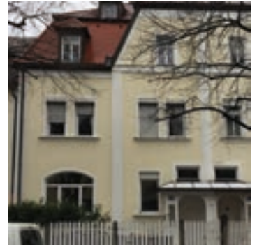
Vor der Renovierung
