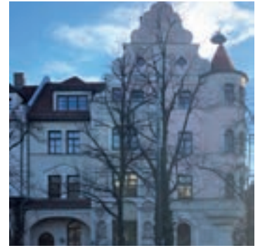
Vor der Renovierung
