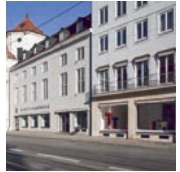
Vor der Renovierung
