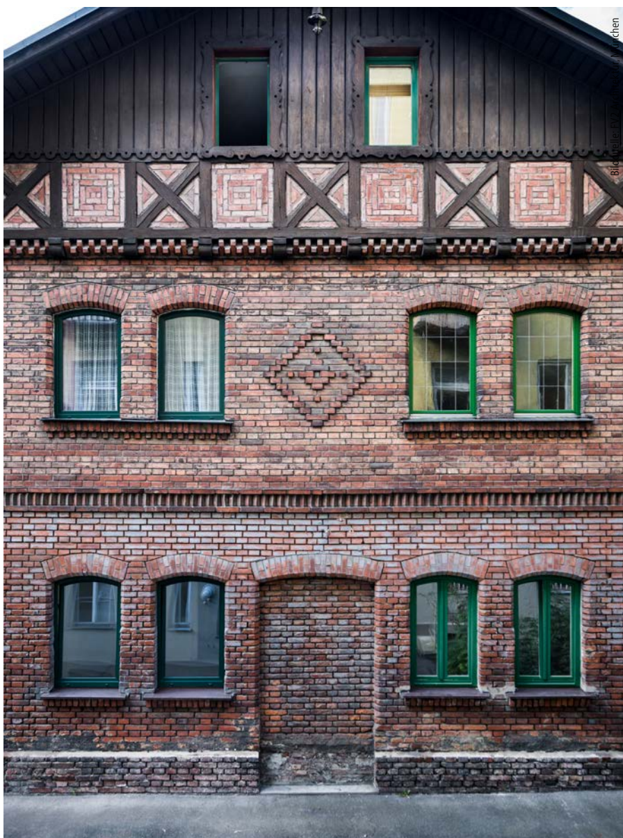
Abb. 1: Von der Straße aus lässt sich das Wohnhaus mit der besonderen Fassade im historischen Dreimühlenviertel Münchens nur erahnen. So sah der Bestand vor der Sanierung aus.
