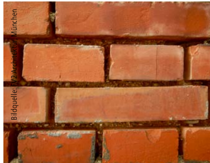
Abb. 7: Mit einem Niederdruck-Wirbelverfahren wurden lokale Verschwärzungen oder Krusten auf der Steinoberfläche reduziert.
