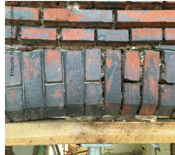
Abb. 3: Die Verwendung von Blendziegeln als Sichtziegel bietet eine Vielzahl an Gestaltungsmitteln für ein ausdrucksstarkes Erscheinungsbild. Für Struktur sorgen die unterschiedlichen Verbände, Farbigkeit der Ziegel, und konstruktive Elemente wie Gesimse und Stürze.
