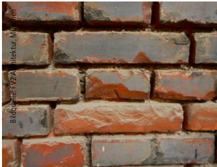
Abb. 6: Verschmutzungen, die sich im Laufe der vergangenen 120 Jahren auf den Blindziegeln angesammelt hatten, wurden zuerst vorsichtig erneuert.
