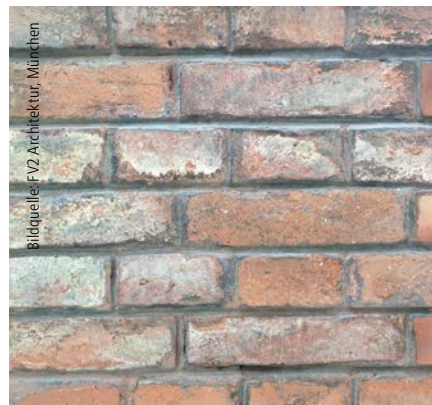
Abb. 4: Die Farbigkeit der Fassade wird zudem bestimmt vom Fugenbild, abhängig von Fugenbreite sowie der Zusammensetzung des Fugenmaterials und damit dessen Farbton.
