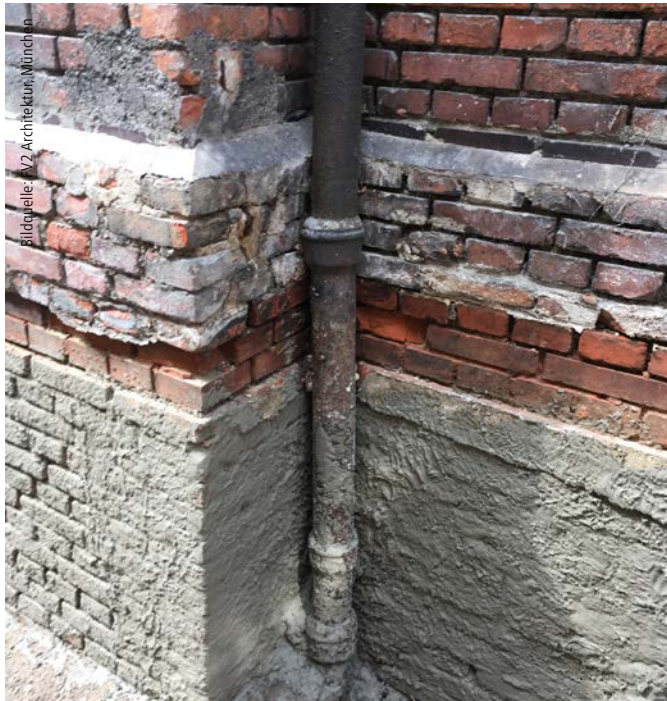
Abb. 11: Die Oberseite des freigelegten Sockels wurde mit Dichtschlämmen gegen die Feuchtigkeit abgedichtet.
