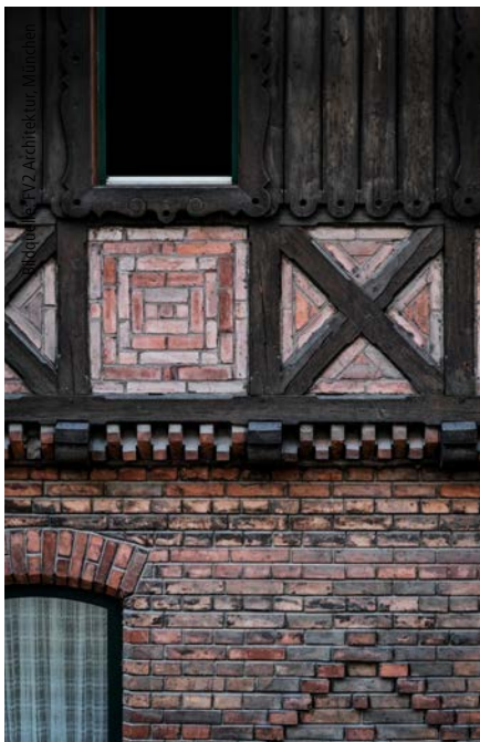
Abb. 8: Unter den Schmutzschichten kam das zweifarbige Sichtziegelmauerwerk im Obergeschoss zum Vorschein, das heute zusammen mit dem Fachwerkkniesock den einzigartigen Charakter der Fassade bestimmt.
